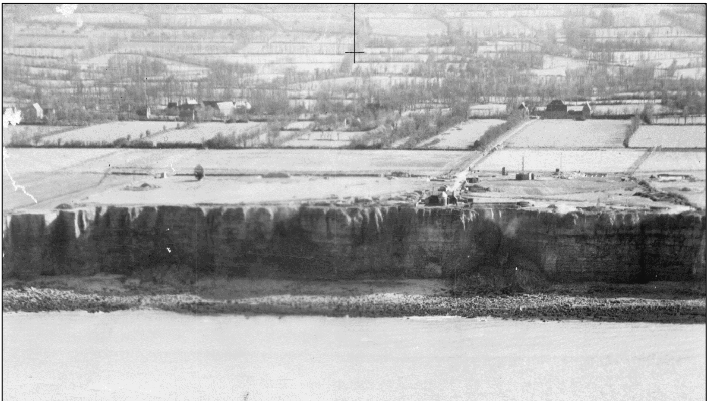
Stützpunkte [StP] 74a at Le Guay, Pointe de La Percée near Englesqueville- La-Percée.
